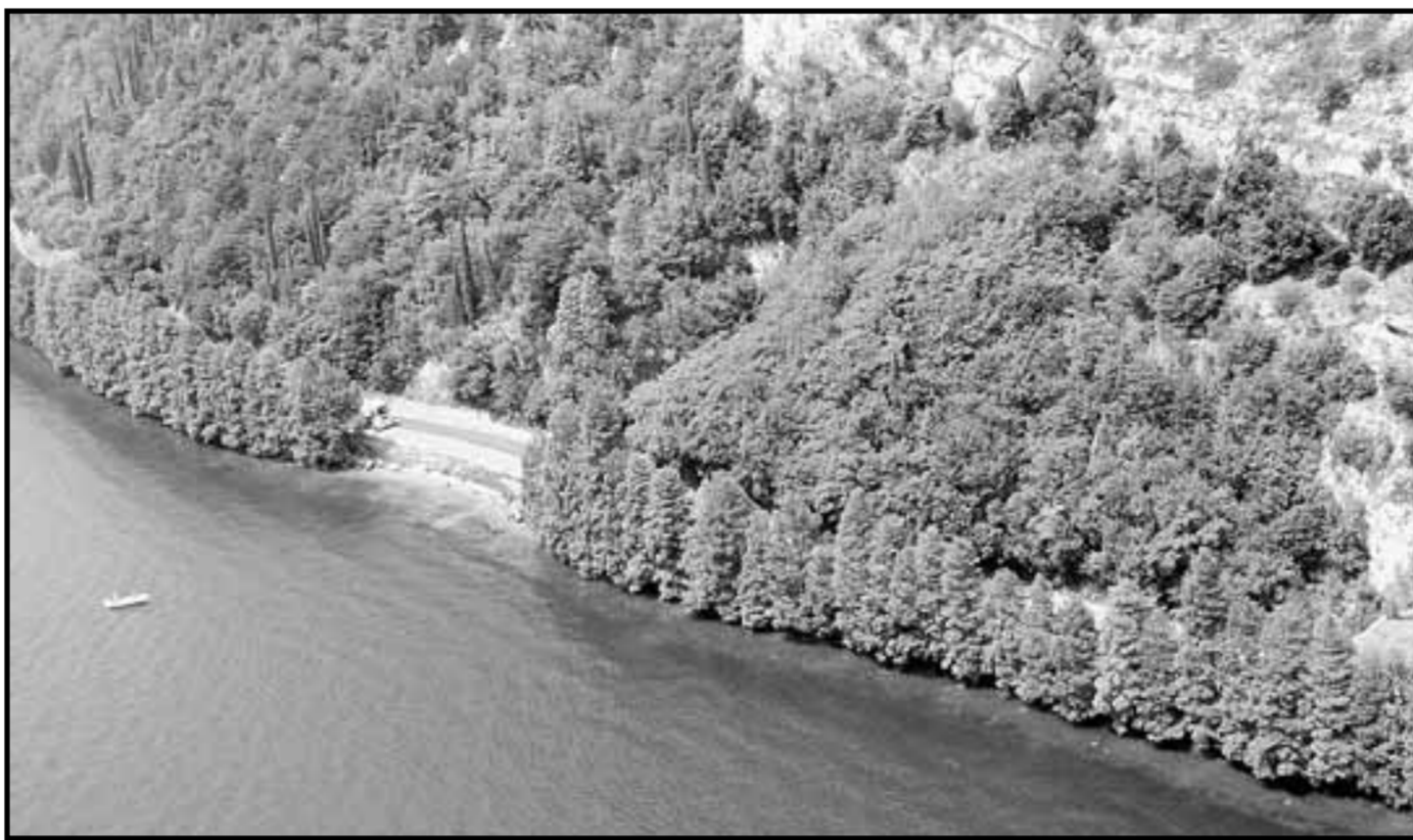
Il tratto di sponda del Sebino dove sarà realizzata l'area attrezzata e il pontile per i windsurf
