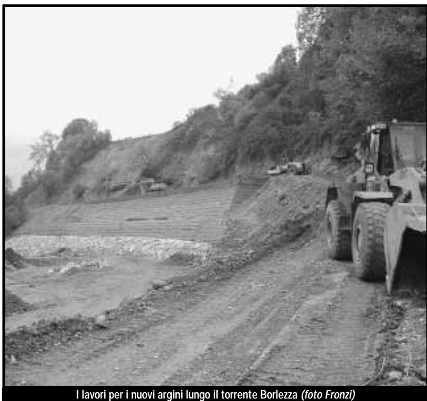
I lavori per i nuovi argini lungo il torrente Borlezza (foto Fronzi)
